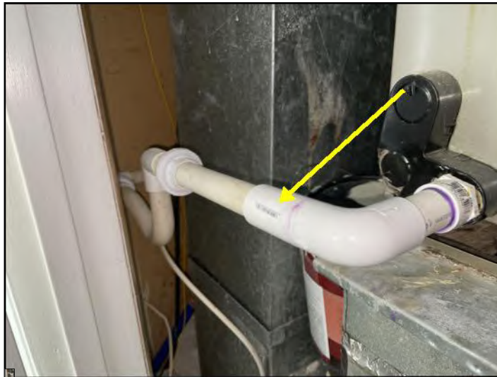
Condensate drain
