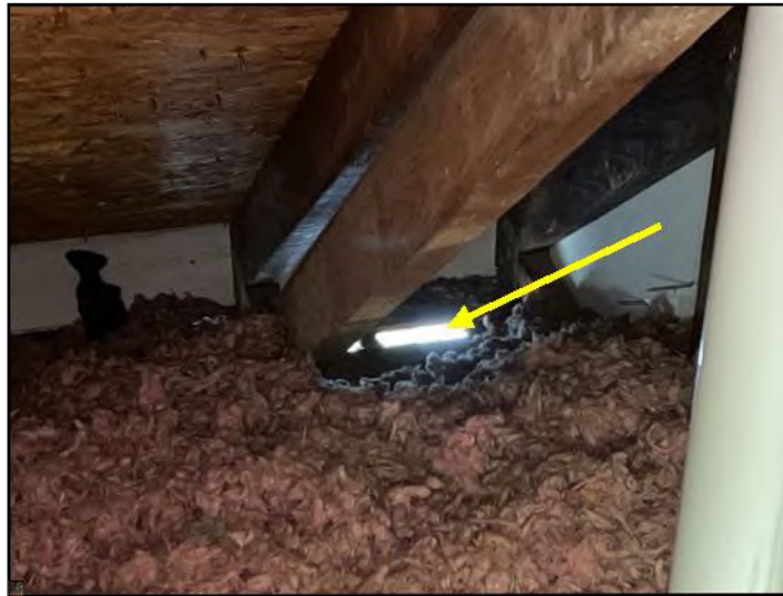
Soffit vent
