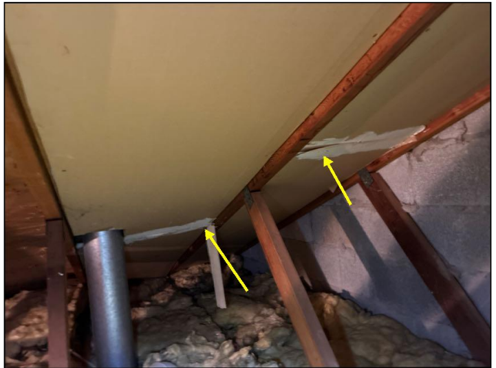
Peeling drywall tape
